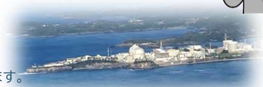
九州電力㈱玄海原子力発電所
