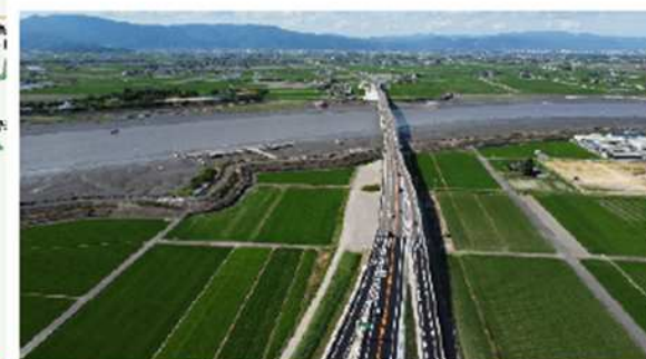
② 有明海沿岸道路（芦刈南IC～福富IC） 令和3年7月24日開通
